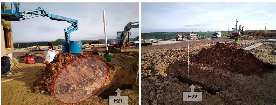
Figure 3 - Vues de la zone d'implantation retenue pour la nouvelle installation d'assainissement non collectif.
